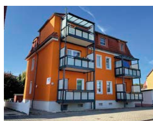
Luckaer Straße 11 MEUSELWITZ
