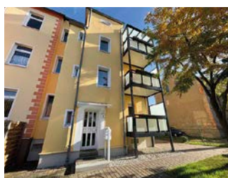
Luckaer Straße 7 MEUSELWITZ
