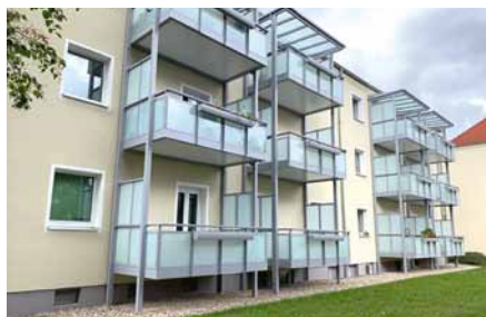
Puschkinweg 2-4 · Bad Dürrenberg
