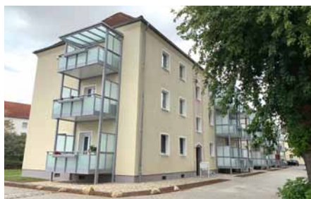
Puschkinweg 6-12 · Bad Dürrenberg
