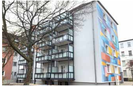
Freiimfelder Straße 91-93 · Halle
