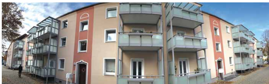
Puschkinweg 9-19 · Bad Dürrenberg
