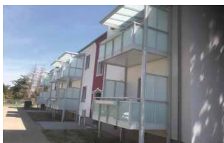
Puschkinweg 14-16 · Bad Dürrenberg
