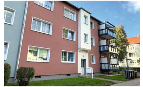
Gollmaer Straße 2-6 · Halle
