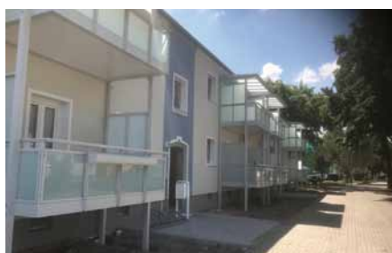
Puschkinweg 21-23 · Bad Dürrenberg
