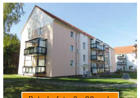
Bahnhofstraße 29 a – b Lucka
